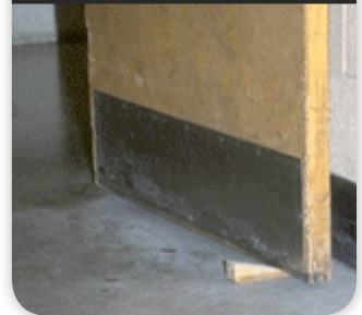
USING DOOR CHOCK TO HOLD OPEN A FIRE DOOR
